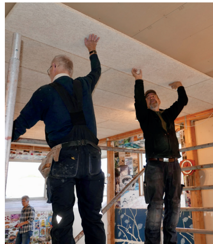
Erling og Lars sætter de manglende loftsplader op.
